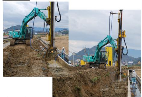
バックホウタイプの地盤改良機であることから、ベースマシンと施工基面の高低差があっても、アームを伸ばしリーダ部分を下げることで、施工が可能であり、機械足場用のステージを設置する必要がない。また、地盤改良機足場が多少軟弱であっても、転倒の心配がない。
