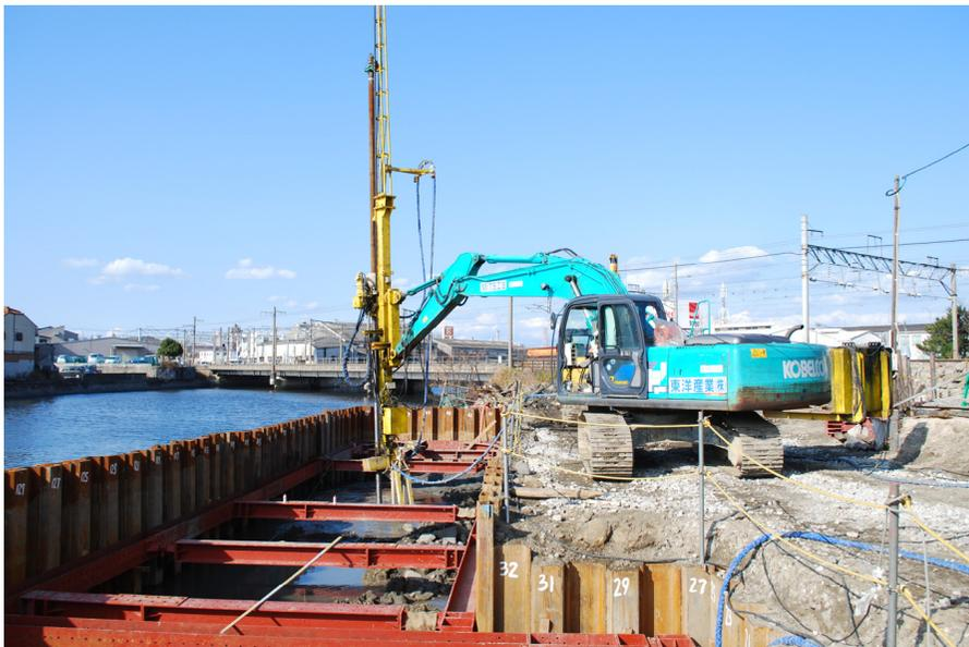
バックホウタイプの地盤改良機であることから、ベースマシンと施工基面の高低差があっても、アームを伸ばしリーダ部分を下げることによって、施工が可能であり、機械足場用のステージを設置する必要がない。
