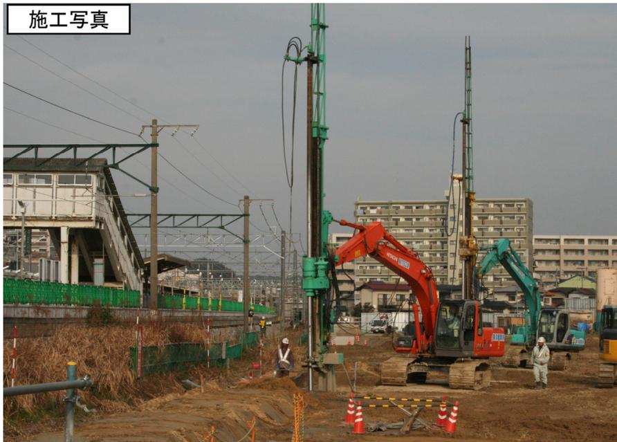
小型のバックホウタイプ地盤改良機であることから、機械の移動が容易であり、アームを伸ばして施工できることから、狭い場所でも2台施工が可能である。また、バックホウタイプであることにより、転倒の心配がなく、鉄道近接工事が可能である。
